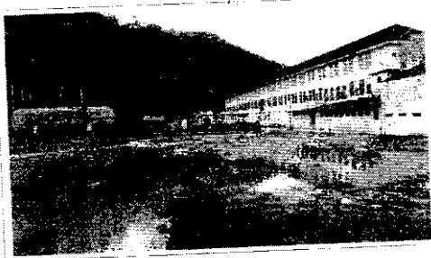
Foto 05: Vista Estação de Descompressão (RCU) após o evento.
