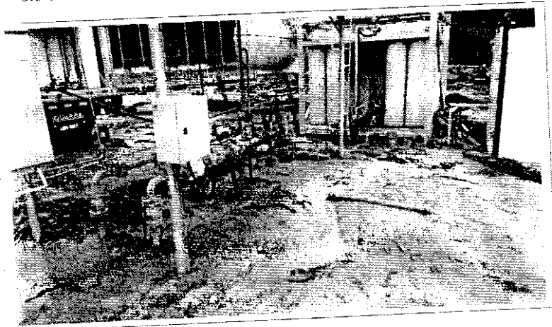
Foto 02. Vista da Estação de Descompressão (RCU) após o evento.
