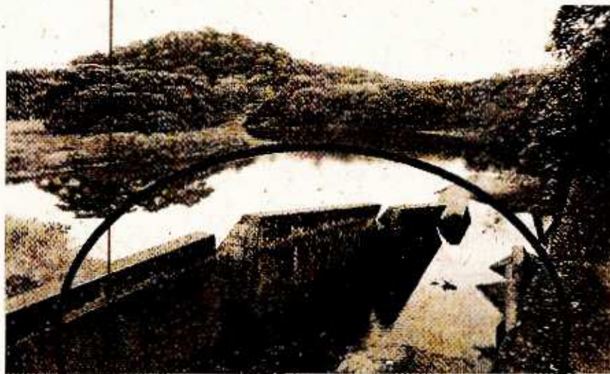
FOTO 1 - CANAL DA MARGEM DIREITA
