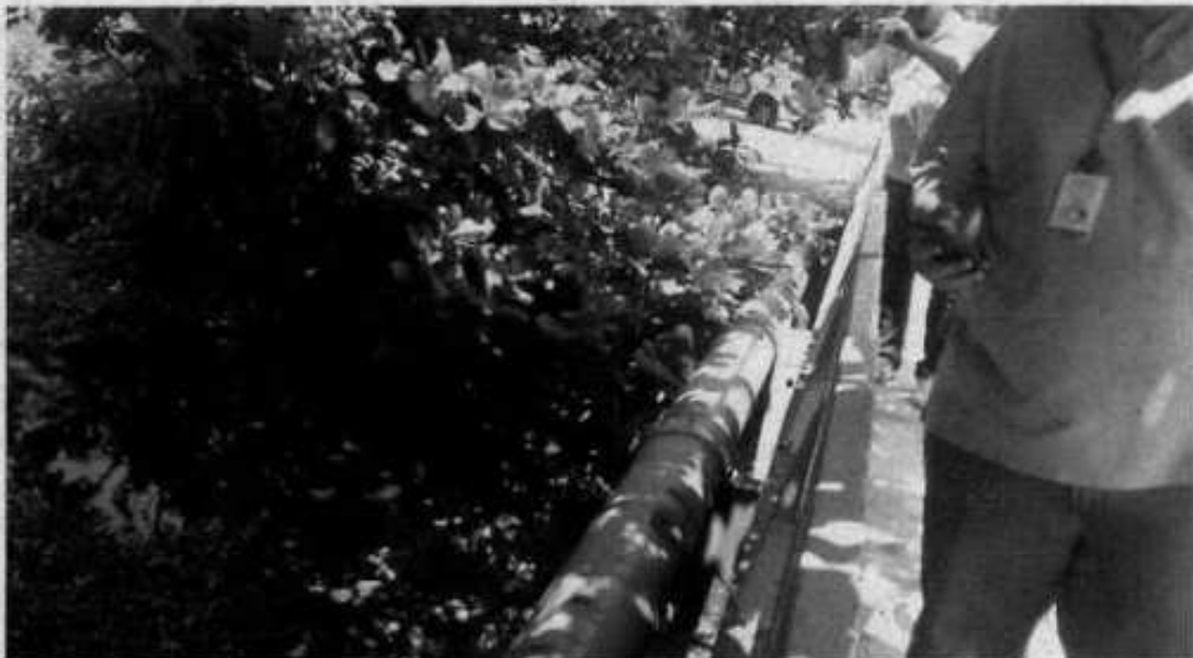
AVENIDA TEOTÔNIO VILELA COM AVENIDA AVENIDA HENFIL - RECREIO DOS BANDEIRANTES ADUTORA DE DIÂMETRO DE 400 MM - VISTORIA TÉCNICA - MARÇO 2017
