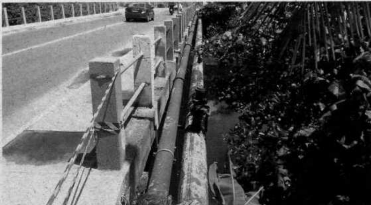
ESTRADA ALCEU DE CARVALHO COM A ESTRADA DO PONTAL - RECREIO DOS BANDEIRANTES VENTOSA NA ADUTORA DE DIÂMETRO DE 400 MM - VISTORIA TÉCNICA - MARÇO 2017
