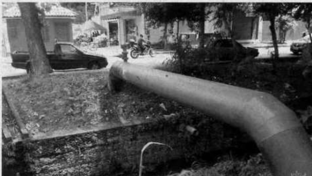
ESTRADA DOS BANDEIRANTES X RUA CLÁUDIO JACOBY - BAIRRO VARGEM PEQUENA VENTOSA EM ADUTORA DE DIÂMETRO DE 600 MM - VISTORIA TÉCNICA - MARÇO 2017
