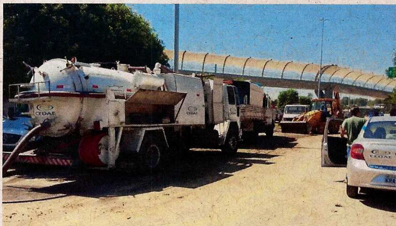
MAQUINÁRIOS UTILIZADOS NOS SERVIÇOS DE REPARO
