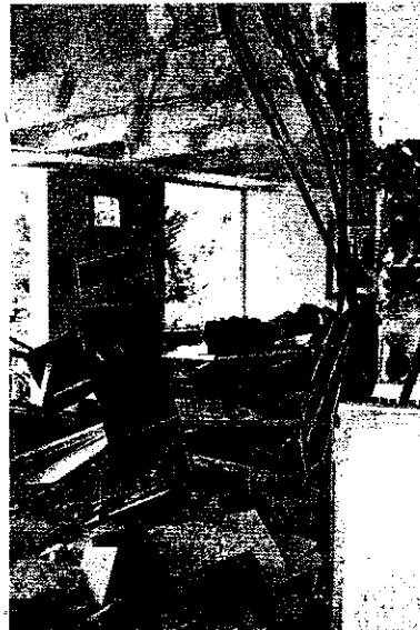
Foto 27 - Sala do apartamento 1001, onde pode ser visto ao fundo a parede divisória com a varanda e o rebaixamento de gesso destruída, além dos destroços espalhados por toda a sala
