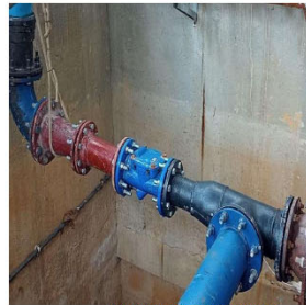
Remanejamento Provisório da Rede de Recalque de Esgoto
