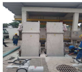
Instalação das grades mecânicas
