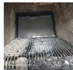
Montagem de grade fixa
