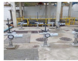
Instalação dos atuadores elétricos
