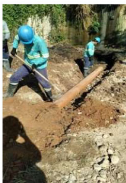
Reaterro da Tubulação
