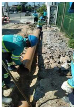
Instalação dos Materiais
