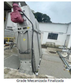
Grade Mecanizada Finalizada
