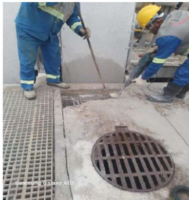
Montagem da Grade Mecanizada
