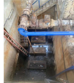
Desmontagem e Remoção Manual de Equipamentos
