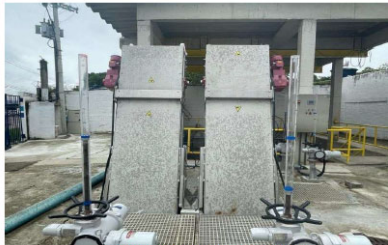
Grade Mecanizada Finalizada
