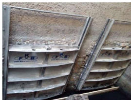
Instalação das comportas
