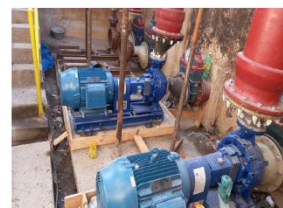
Instalação de conjunto moto bomba KSB
