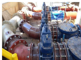
Montagem de Bombas e tubulações.
