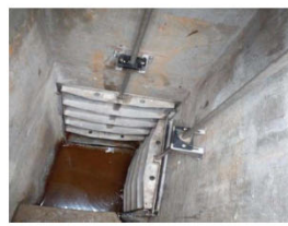
Instalação das comportas
