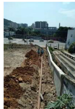
Instalação da Tubulação
