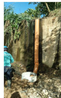
Instalação da Tubulação
