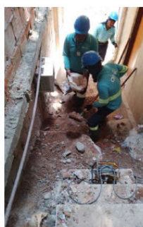
Abertura de Vala
