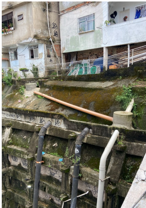
Foto 11 - Último PV (início da obra)
