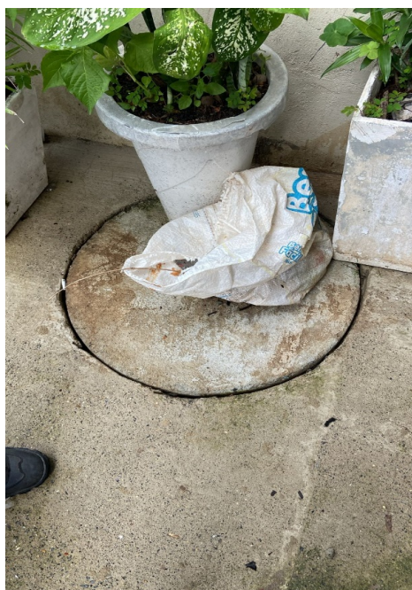
Foto 4 - PV com tampa de concreto e concretagem
