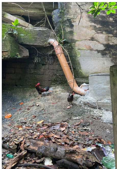
Foto 9 - PV com tampa de concreto e três anéis
