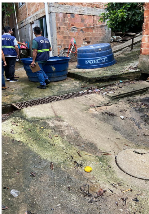
Foto 3 - PV com tampa de concreto e concretagem
