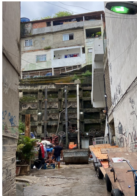
Foto 12 - Último PV (início da obra)
