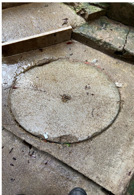
Foto 2 - PV com tampa de concreto
