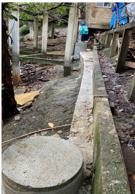
Foto 7 - PV com tampa de concreto e concretagem
