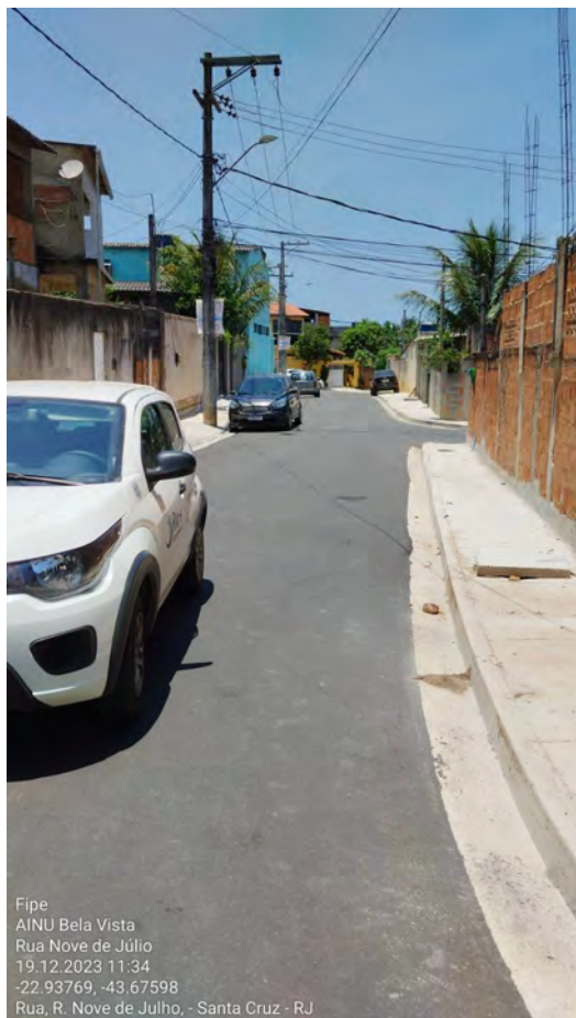
Foto 12 - Rua Nove de Julho
