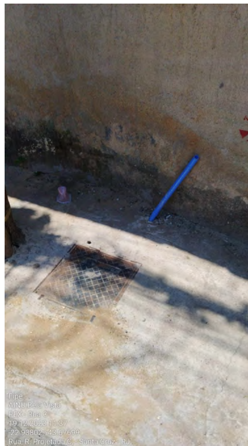
Foto 9 - PEAD Instalado - Rua Proj. C
