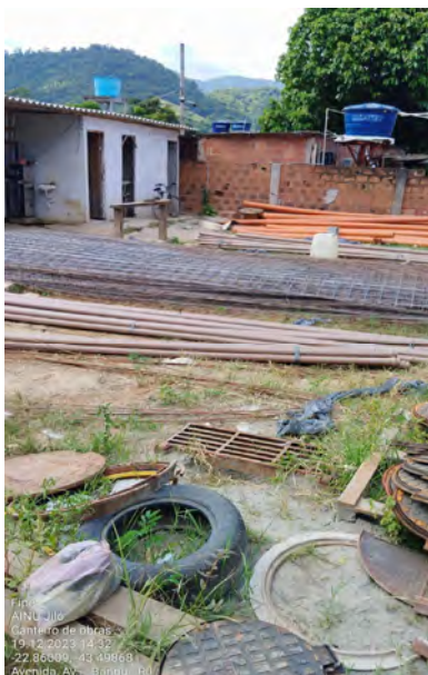
Foto 14 - Canteiro de Obras - Hydra
