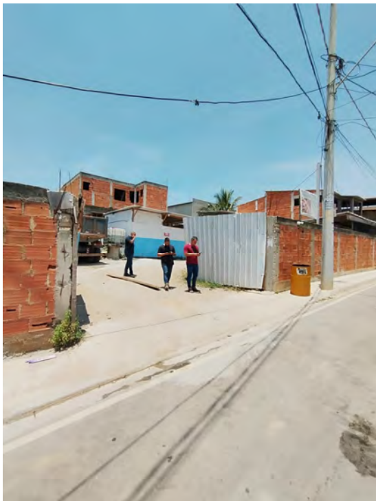
Foto 1 - Canteiro de Obras - R2X
