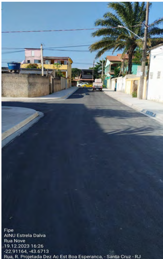
Foto 27 - Rede de água já assentada, R. 9
