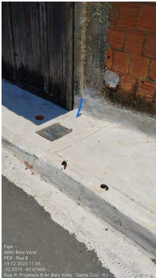
Foto 6 - PEAD Instalado - Rua B
