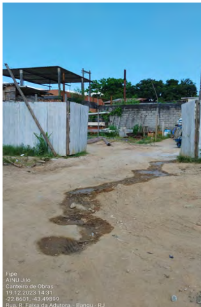
Foto 13 - Canteiro de Obras - Hydra
