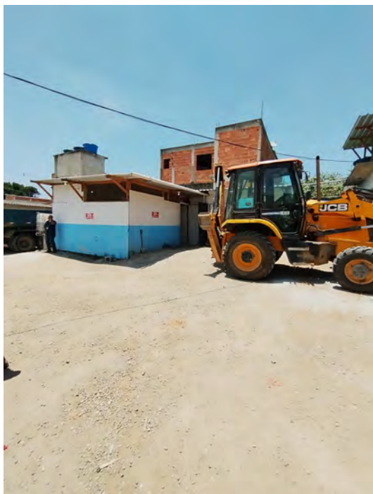
Foto 2 - Canteiro de Obras - R2X
