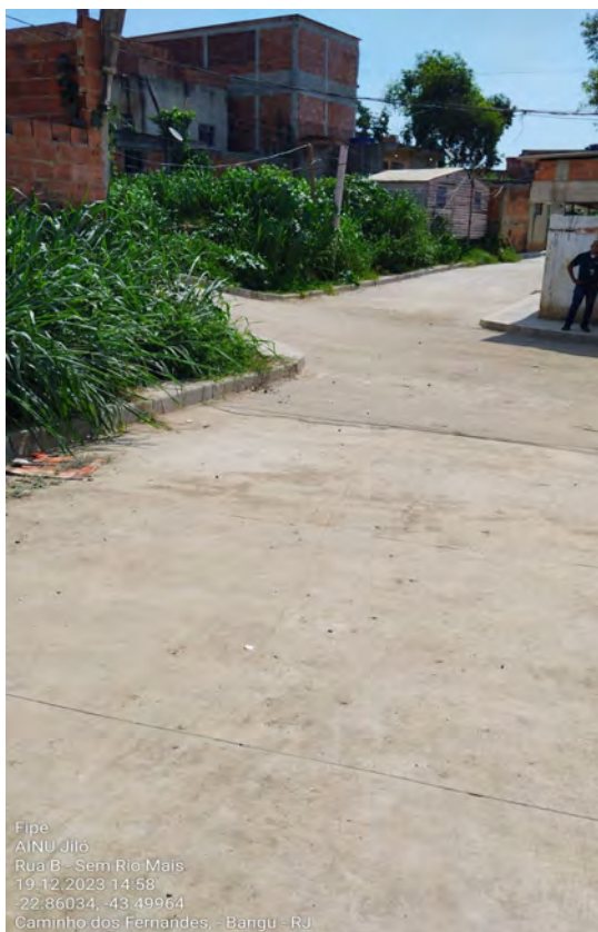
Foto 21 - Rua B (Exec. c/ material próprio)
