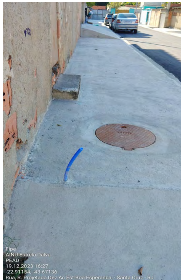
Foto 28 - PEAD instalado – Rua Proj 9
