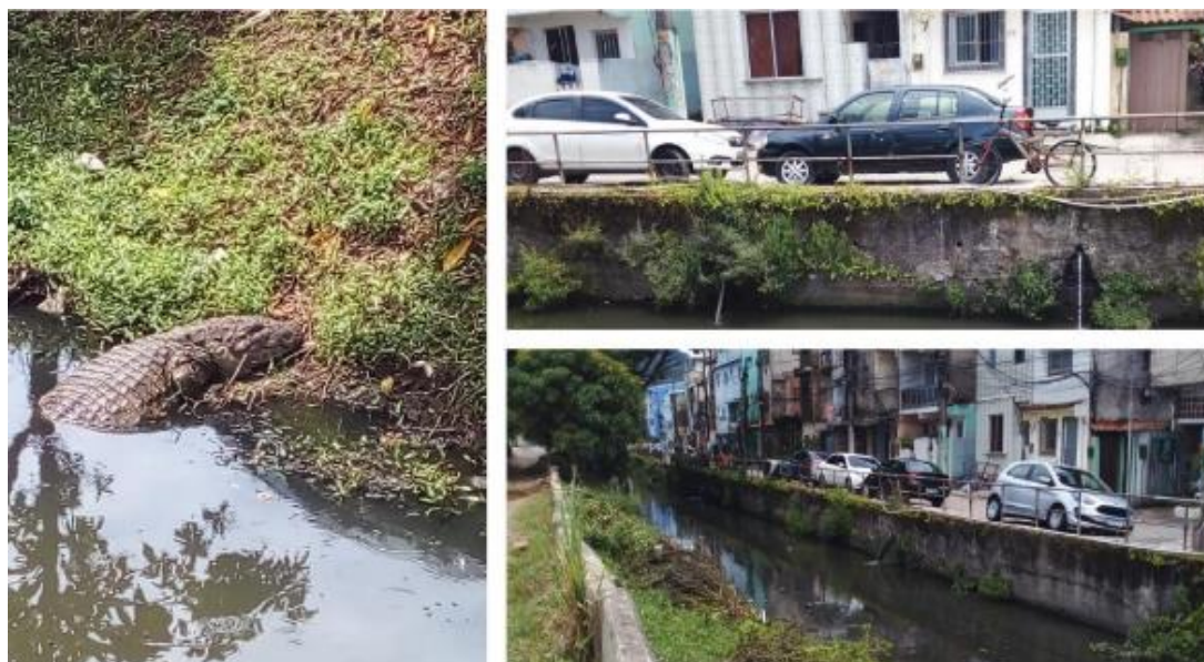
Figura 13: Fotos do Canal das Tachas – trecho próximo da comunidade Rua 8W,500
