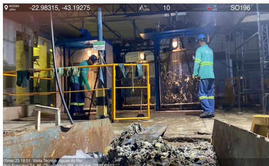
Foto 14 - Elevatória André Azevedo
