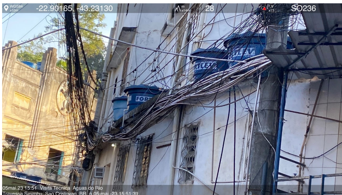
Foto 11: Comunidade da Mangueira, outro exemplo de ligações de água existentes, realizadas pelos moradores, e que serão readequadas pelo plano de investimentos.
