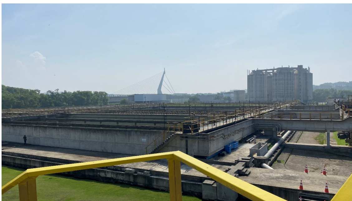
Foto 6: Estação de Tratamento de Esgotos (ETE) Alegria, vista panorâmica da estação.
