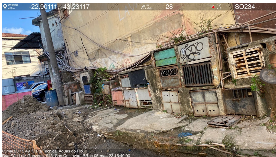
Foto 10: Comunidade da Mangueira, exemplo de ligações de água existentes, realizadas pelos moradores, e que serão readequadas pelo plano de investimentos.
